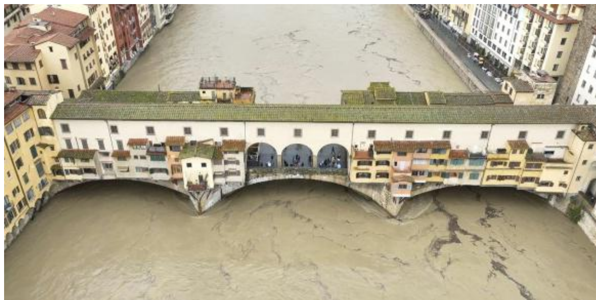
Uno scatto dal drone realizzato dal fotografo pilota Jacopo Bianchi, mostra il Ponte Vecchio che 'lotta' con l'Arno
